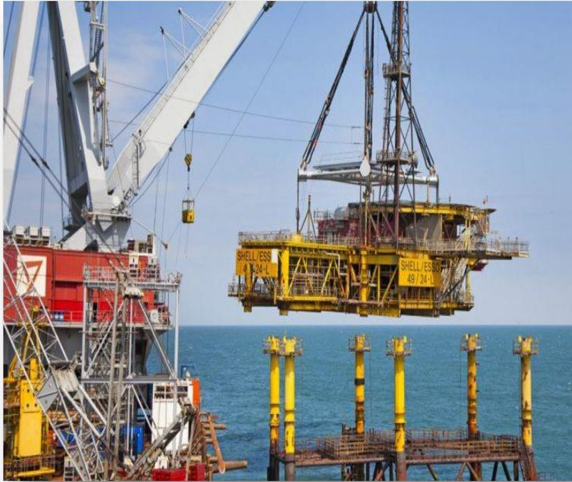
**Fig 1: Foto ilustrativa de Retirada de um Convés**
