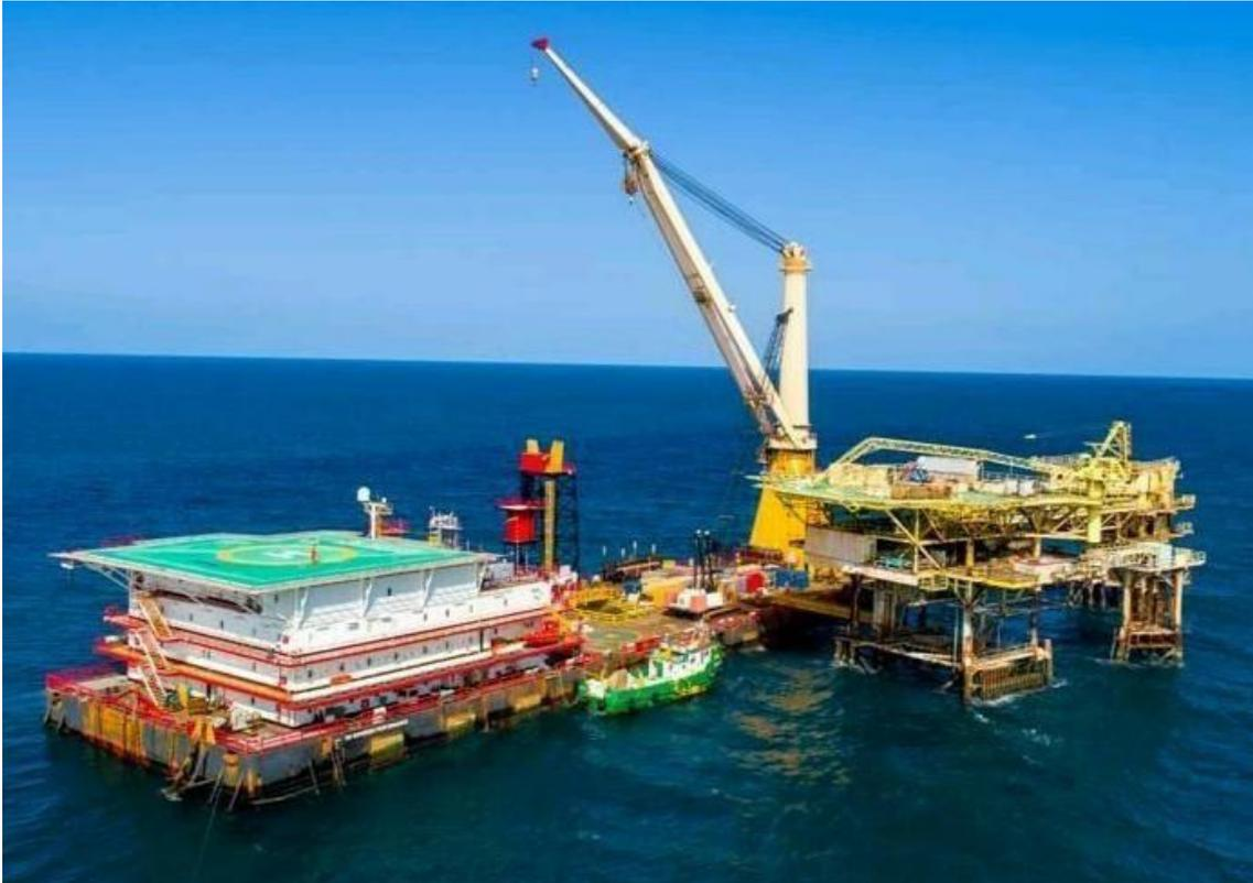
**Fig 9: Operação de descomissionamento da Plataforma de Cação na Costa de São Mateus-ES**
